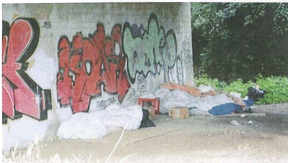
ABBANDONO Ecco il punto sotto il viadotto Kennedy con i materassi
