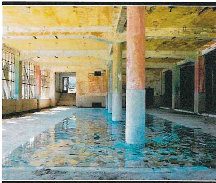
L'interno della sala Milleluci come si trova oggi, in disuso da decenni
