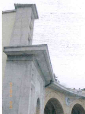
Figura 142 - Punto del cornicione sede d'installazione
