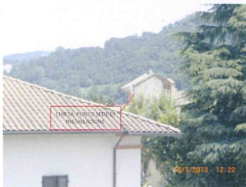
Figura 104 - Punto sulla Chiesa adiacente alla Piazza, sede di installazione
