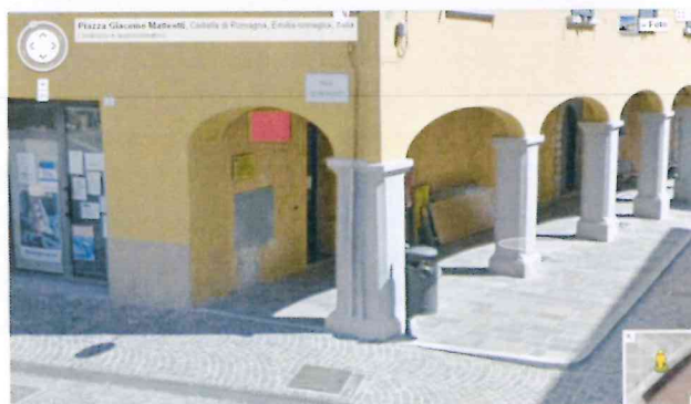
Figura 131 - Punto di collocazione del Rack outdoor
