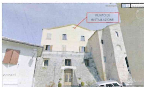
Figura 202 - Punto sede d'installazione, lato Comune
