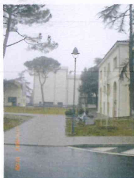
Figura 111 - Parcheggio del Teatro visto dal palo di illuminazione sede d'installazione
