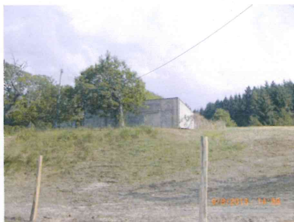
Figura 60 - Acquedotto di Acquapartita
