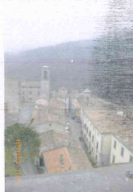
Figura 16 - Palazzo Guidi, visto dalla torre, sede d'installazione
