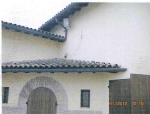
Figura 144 - AP outdoor attualmente installato
