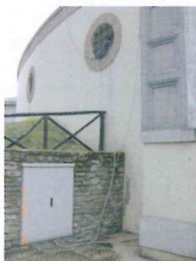
Figura 140 - Punto in cui verrà posto l'armadio ottico della fibra, dietro a Piazza Garibaldi
