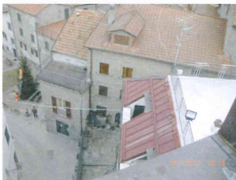
Figura 114 - Balcone privato, sede d'installazione, visto dalla Torre
