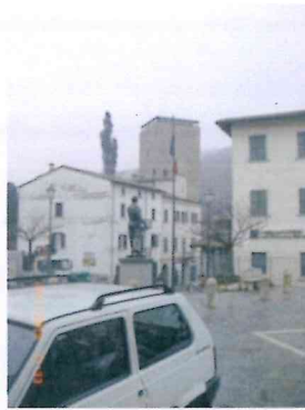
Figura 14 - Torre Portinari, vista dal Comune
