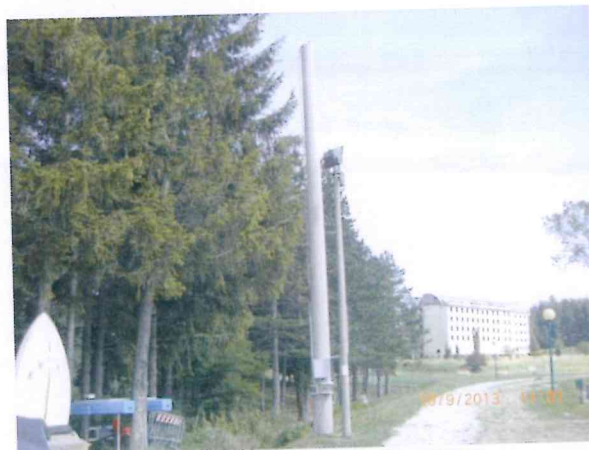
Figura 62 - Palo adiacente al Lago
