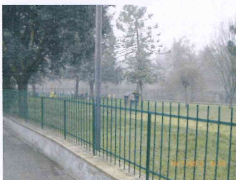
Figura 2 - Palo pubblica illuminazione, sede d'installazione
