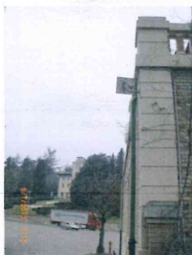
Figura 136 - Antenna che effettua un collegamento punto-punto tra il Comune e gli Uffici comunali su cui è alloggiata
