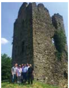
La cittadina di Meldola dominata dalla rocca (in alto); sopra, la Rocca di Castelnuovo. A fronte, il Ponte dei Veneziani e la chiesa di Scardavilla.
