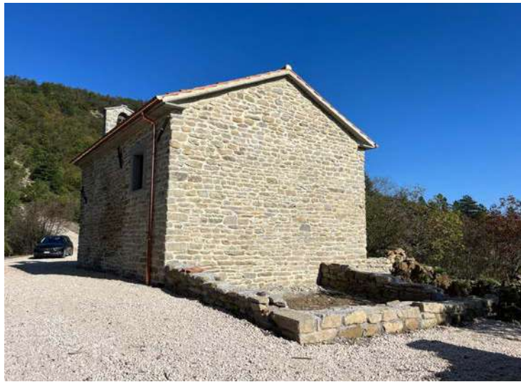
Il rifugio chiesa del Mangano appena restaurato
